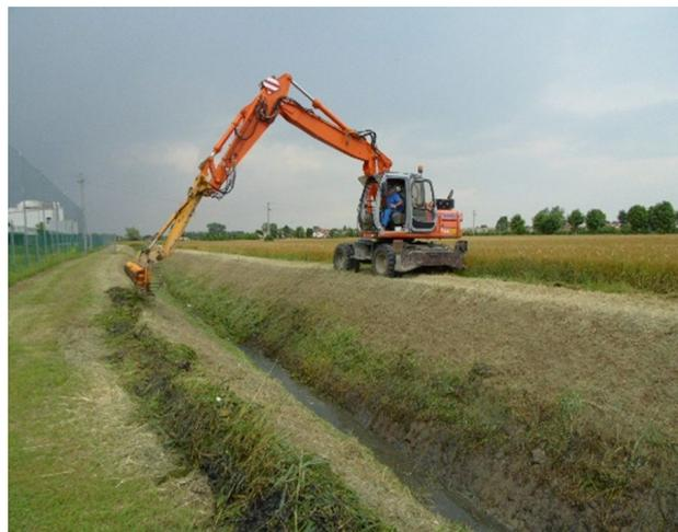
**Foto 6** – Escavatore con benna falciante per la gestione della biomassa di sponda (Fonte CREA)
